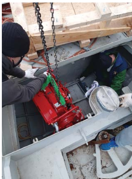
Ważna chwila: montaż nowego silnika.
