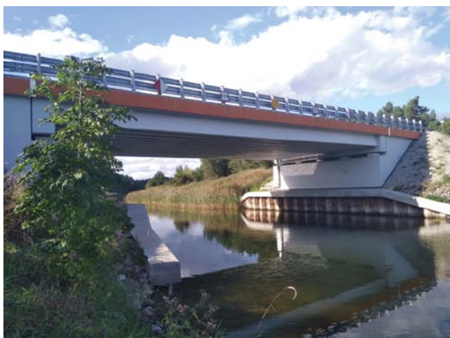
Wyremontowany most nad Kanałem Jeglińskim.
