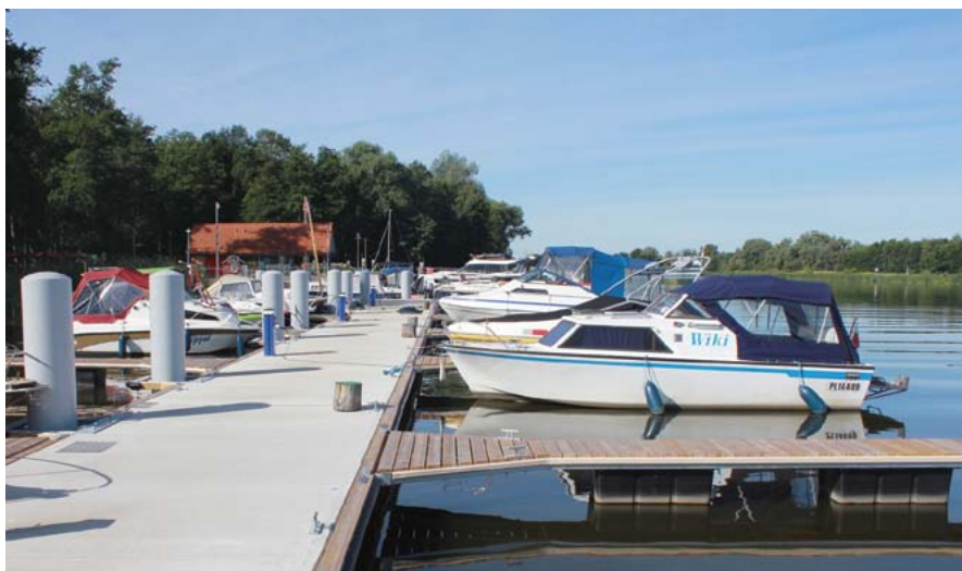
Przystań Park Północny w Malborku rozbudowano o nowe pomosty.
