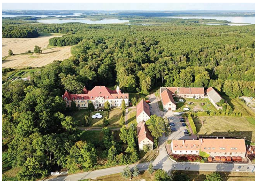
Z lewej pałac. Pośrodku spichlerz i rybaczówka. Z prawej budynki gospodarcze, a przy drodze – pensjonat, Mesa i Żęza.
