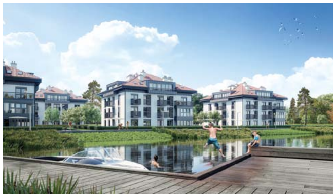
W Dziwnowie powstaje pięć pierwszych budynków (realizacja na IV kwartał 2021 roku).
