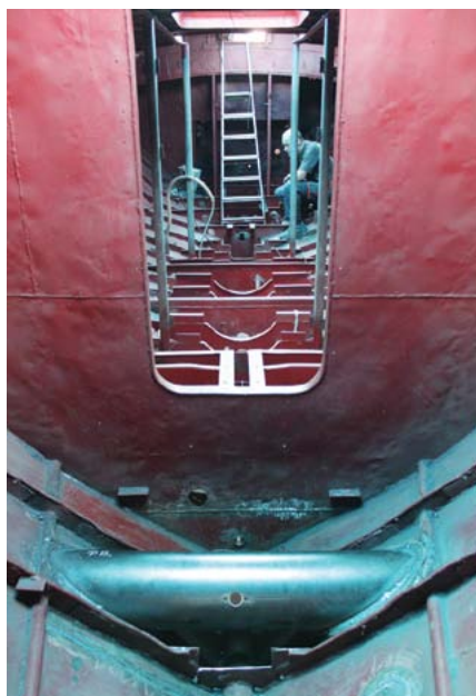
Wnętrze po pracach stocznioowych.
