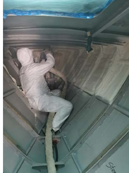
Ocieplenie wykonano metodą natryskową.
